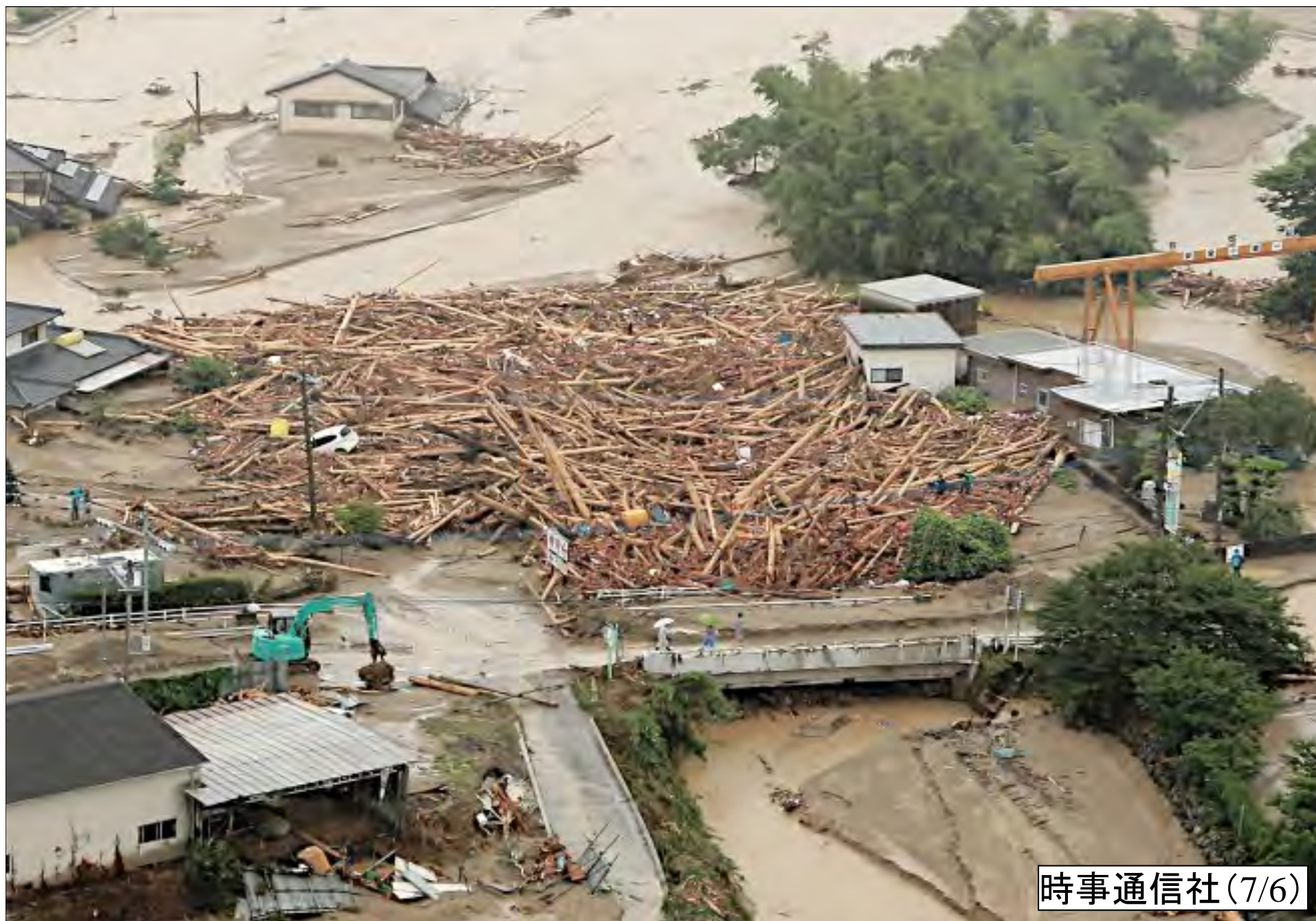
北川・本陣橋付近に集積して河道を閉塞した流木（土砂流氾濫の原因となる）
