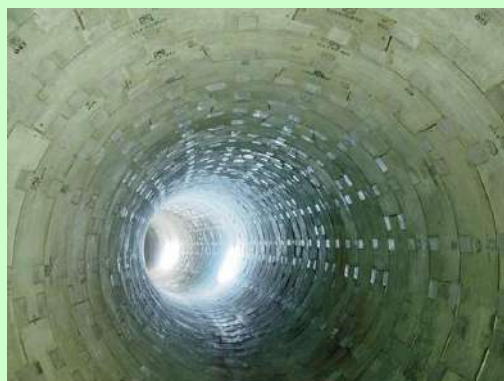
桜町北湊雨水貯留管の内部 出典：鹿島建設(株)HP
