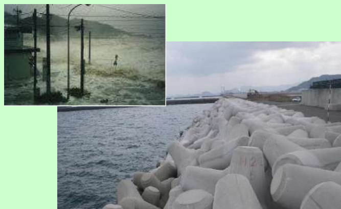
新門司地区における護岸整備状況
